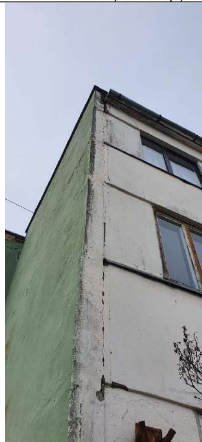
8.att. Atbilstoši atsevišķu dzīvokļu īpašnieku sniegtajai informācijai, nokrišņu ūdens caur spraugām norobežojošajās konstrukcijās iekļūst arī dzīvokļos.
