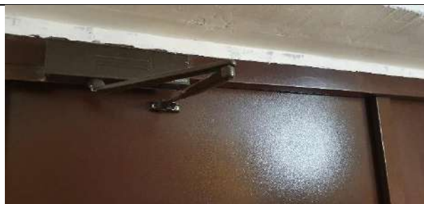
6.att. Ēkas ārdurvis aprīkotas ar aizvērējmehānismu. Reizi gada ieteicams pārbaudīt vai durvis blīvi aizveras un, nepieciešamības gadījumā, veikt aizvērējmehānisma apkopi vai durvju blīvģumiju nomaiņu.
