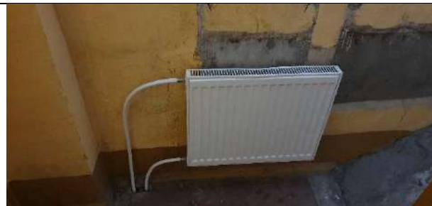
7.att. Ēkā ierīkota viencauruļu apkures sistēma. Ēkā sākotnēji dzīvokļos ierīkoti konvektori, taču dažos dzīvokļos un kāpņu telpā veikta sildķermeņu nomaiņa.
