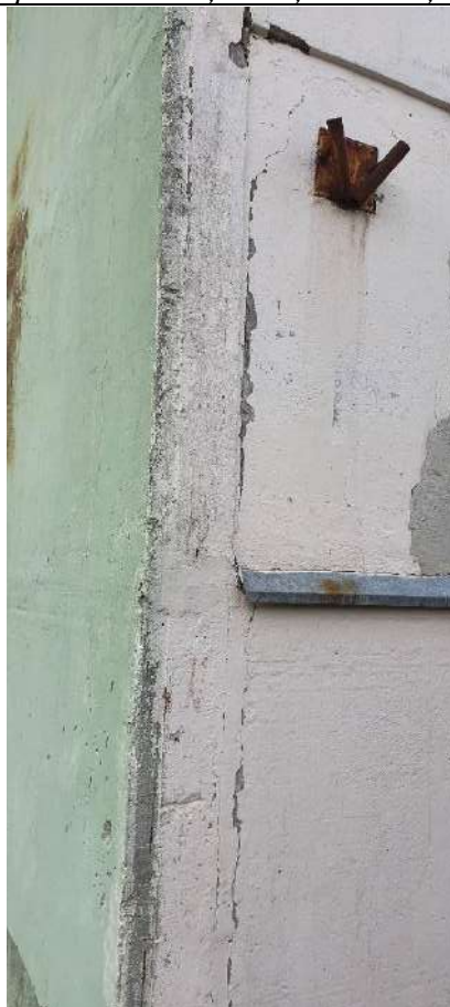
8.att. Atbilstoši atsevišķu dzīvokļu īpašnieku sniegtajai informācijai, nokrišņu ūdens caur spraugām norobežojošajās konstrukcijās iekļūst arī dzīvokļos.
