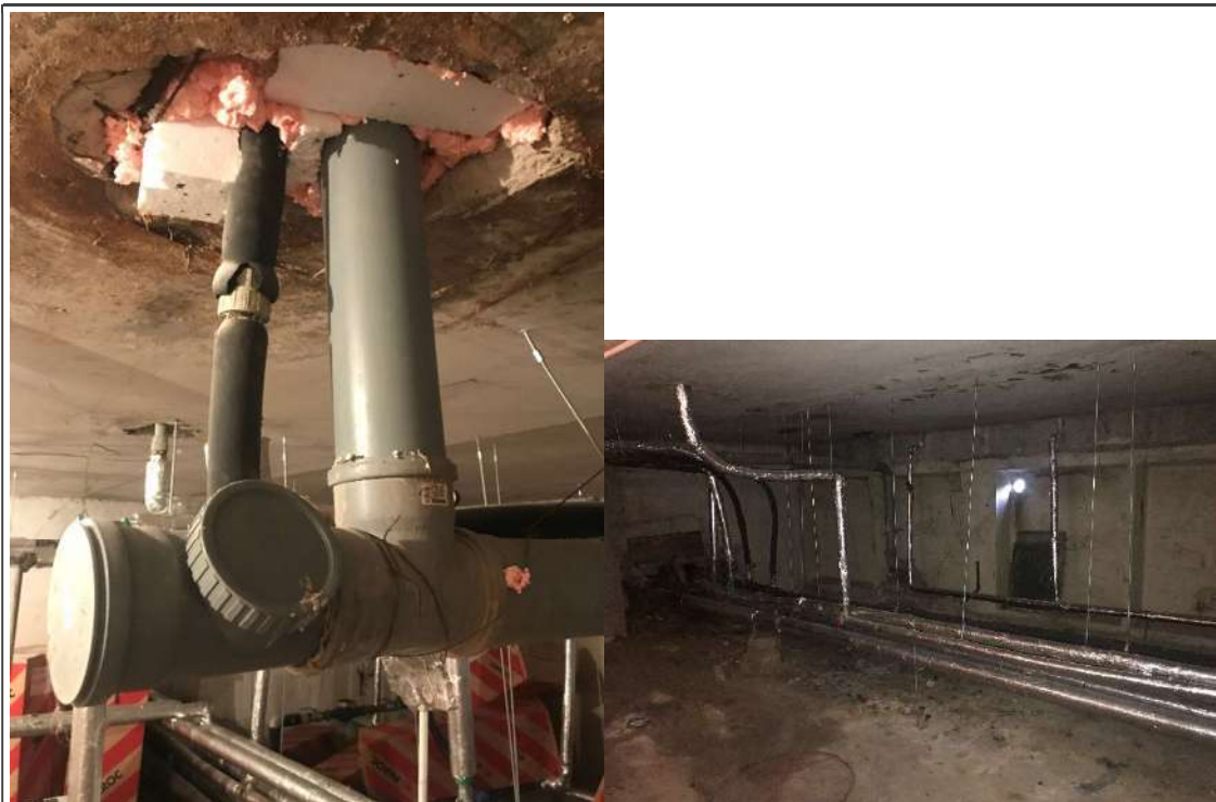
Sadzīves kanalizācijas PVC caurules un pilsētas ūdens ievadi ēkā
