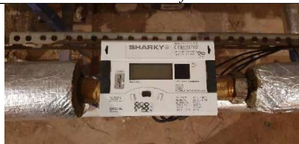
4.att. Ēkā ierīkots atkarīgā pieslēguma tipa siltummezgls ar karstā ūdens sagatavošanu. Uz ēku padodamais siltumenerģijas daudzums tiek regulēts atkarībā no āra gaisa temperatūras. Uztādīts viens kopējs siltumenerģijas skaitītājs.
