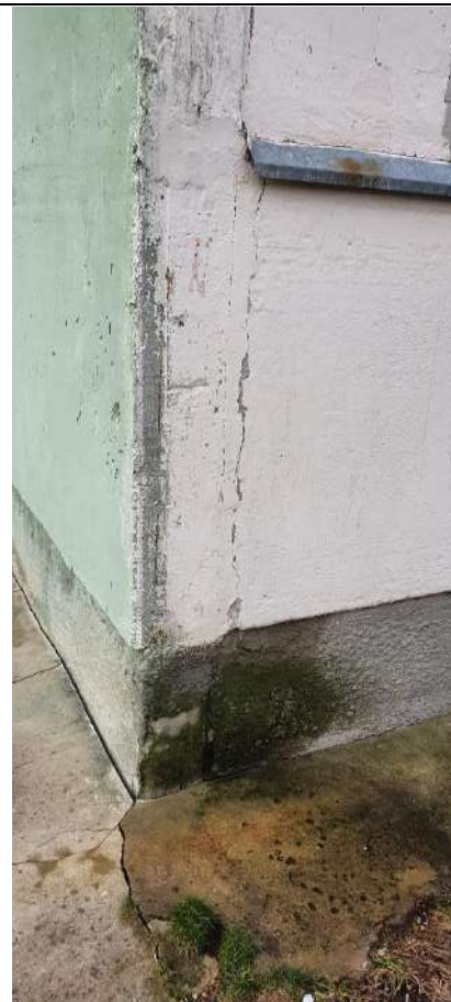
8.att. Atbilstoši atsevišķu dzīvokļu īpašnieku sniegtajai informācijai, nokrišņu ūdens caur spraugām norobežojošajās konstrukcijās iekļūst arī dzīvokļos.
