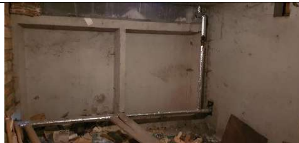
5.att. Ēkā veikta pagrabā esošo apkures un karstā ūdens apgādes cauruļvadu siltināšana. Atsevišķās vietās manāms, ka siltināšana nav veikta pilnībā.
