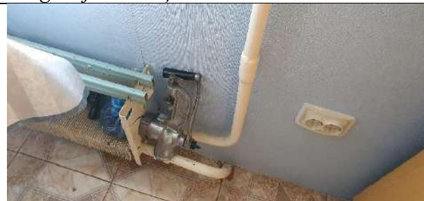
7.att. Ēkā ierīkota viencauruļu apkures sistēma. Ēkā sākotnēji dzīvokļos ierīkoti konvektori, taču dažos dzīvokļos un kāpņu telpā veikta sildķermeņu nomaiņa.
