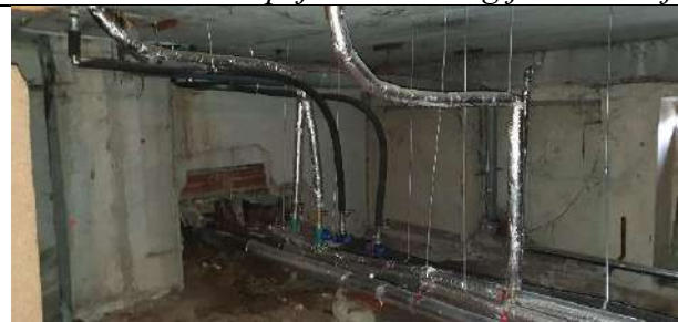
5.att. Ēkā veikta pagrabā esošo apkures un karstā ūdens apgādes cauruļvadu siltināšana. Atsevišķās vietās manāms, ka siltināšana nav veikta pilnībā.
