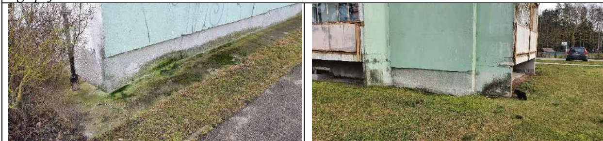
10.att. Veicot ēkas atjaunošanu, nepieciešams sakārtot nokrišņu novadsistēmu un ēkas apmali.
