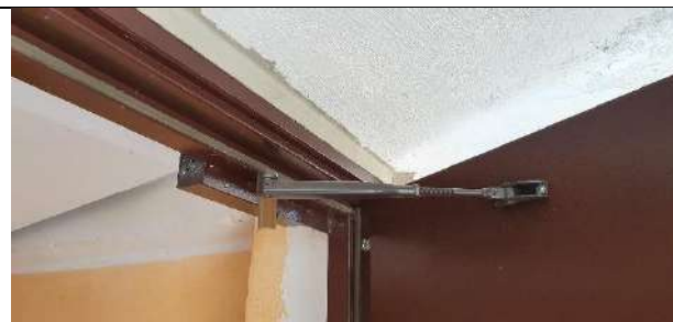
6.att. Ēkas ārdurvis aprīkotas ar aizvērējmehānismu. Reizi gada ieteicams pārbaudīt vai durvis blīvi aizveras un, nepieciešamības gadījumā, veikt aizvērējmehānisma apkopi vai durvju blīvģumiju nomaiņu.
