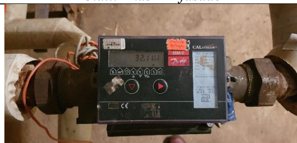
4.att. Ēkā ierīkots atkarīgā pieslēguma tipa siltummezgls ar karstā ūdens sagatavošanu. Uz ēku padodamais siltumenerģijas daudzums tiek regulēts atkarībā no āra gaisa temperatūras. Uzstādīts viens kopējs siltumenerģijas skaitītājs.
