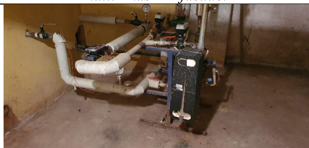
4.att. Ēkā ierīkots atkarīgā pieslēguma tipa siltummezgls ar karstā ūdens sagatavošanu. Uz ēku padodamais siltumenerģijas daudzums tiek regulēts atkarībā no āra gaisa temperatūras. Uzstādīts viens kopējs siltumenerģijas skaitītājs.
