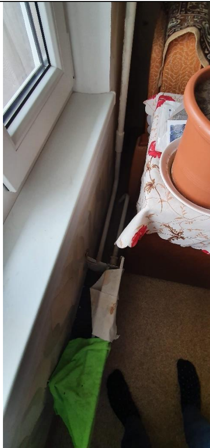
8.att. Ēkā ierīkota viencauruļu apkures sistēma. Ēkā sākotnēji dzīvokļos ierīkoti konvektori, taču dažos dzīvokļos veikta sildķermeņu nomaiņa.
