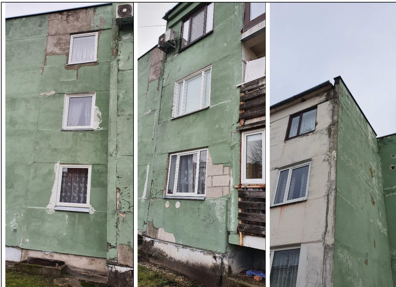
9.att. Uz dažādām ēkas konstrukcijām vērojami bojājumi. Pirms jaunās siltumizolācijas slāņa uzklāšanas nepieciešams novērst konstatētos bojājumus, lai nodrošinātu īstenoto pasākumu ilgtspēju.
