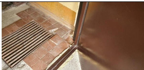
7.att. Ēkas ārdurvis aprīkotas ar aizvērējmehānismu. Reizi gada ieteicams pārbaudīt vai durvis blīvi aizveras un, nepieciešamības gadījumā, veikt aizvērējmehānisma apkopi vai durvju blīvģumiju nomaiņu.
