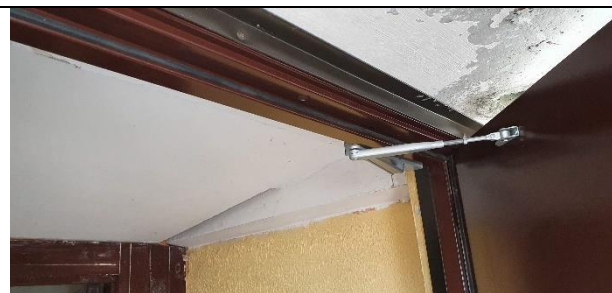
7.att. Ēkas ārdurvis aprīkotas ar aizvērējmehānismu. Reizi gada ieteicams pārbaudīt vai durvis blīvi aizveras un, nepieciešamības gadījumā, veikt aizvērējmehānisma apkopi vai durvju blīvģumiju nomaiņu.
