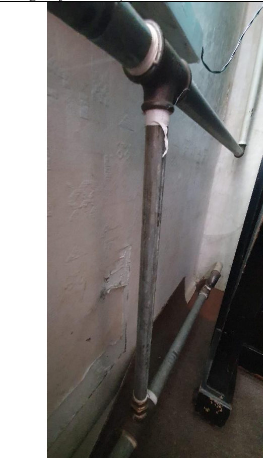
8.att. Ēkā ierīkota viencauruļu apkures sistēma. Ēkā sākotnēji dzīvokļos ierīkoti konvektori, taču dažos dzīvokļos veikta sildķermeņu nomaiņa.
