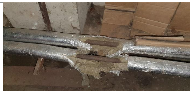
6.att. Atsevišķos posmos siltumizolācijas slānis bojāts.
