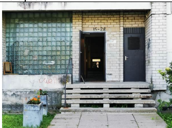
44.att. Betona pakāpieniem trūkst margas vienā pusē
