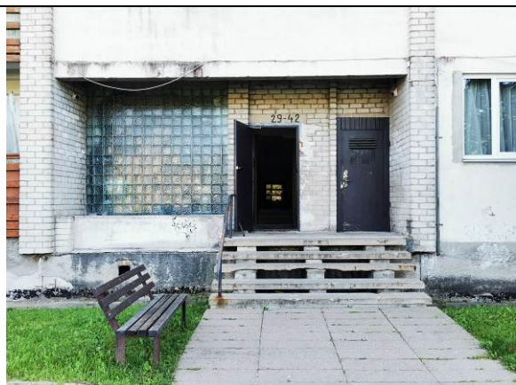
42.att. Betona pakāpieniem trūkst margas vienā pusē
