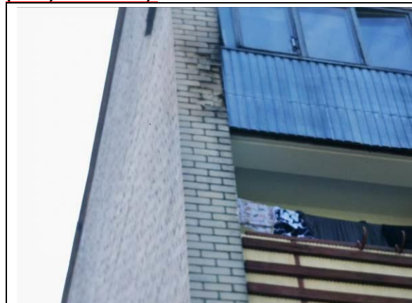
13.att. Lokāli izdrupumi ķ.mūra pilastos
