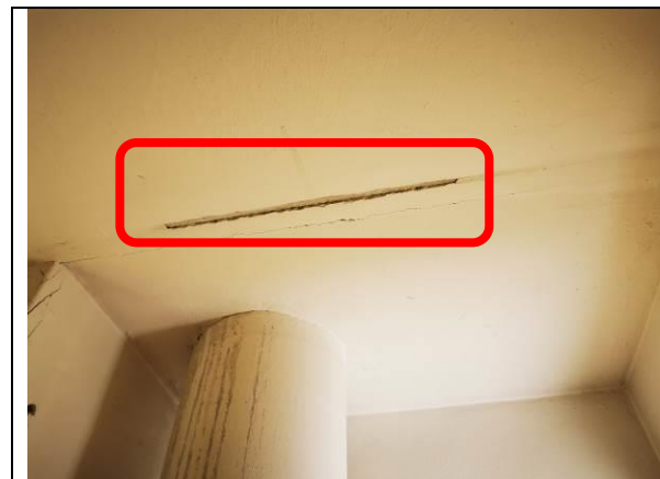
27.att. Izdrupusi starppaneļu šuve
