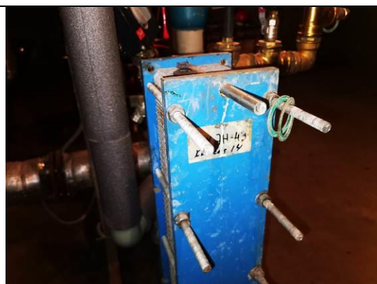
58.att. Karstā ūdens siltummainis nav izolēts
