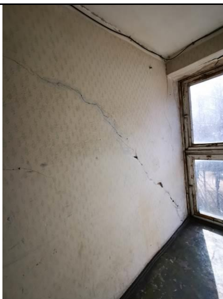
21.att. Plaisa ķieģeļu mūra šķērssienā (gaitenī pie gala ārsienas)
