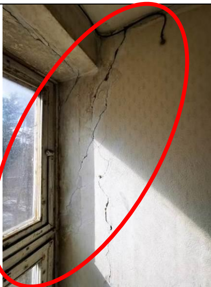
24.att. Plaisa ķieģeļu mūra šķērssienā (gaitenī pie gala ārsienas)
