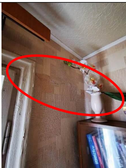
22.att. Plaisa ķieģeļu mūra šķērssienā (5.stāva dzīvoklī pie gala ārsienas)
