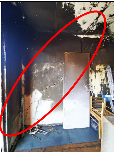
19.att. Plaisa ķieģeļu mūra šķērssienā 5.stāva dzīvoklī
