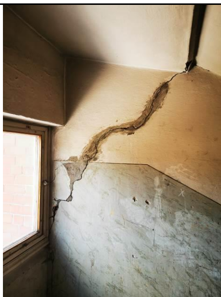
22.att. Plaisa ķieģeļu mūra šķērssienā (centrālā kāpņu telpā)
