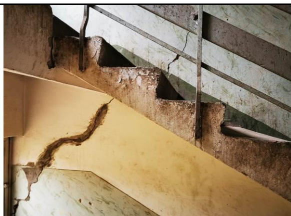
26.att. Plaisa ķieģeļu mūra šķērssienā (centrālā kāpņu telpā)
